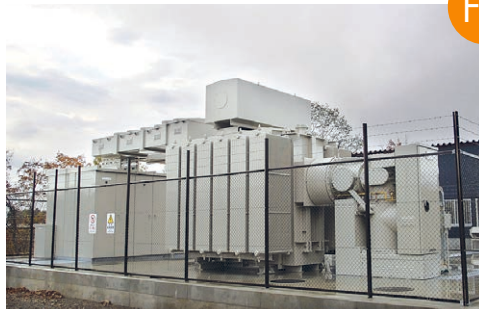
ユーラス豊頃ソーラーパーク 様 交流22MW。66kV特高設備を納入 22MW 北海道
