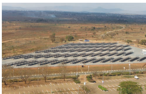
マラウイ共和国 エネルギー省 様 機器一式納入 (100kWパワーコンディショナ×9台など) 830kW マラウイ
