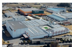
720kW ベネッセコーポレーション
